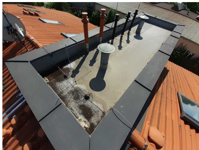
Foto /26/ Plochá střecha na zděné nástavbě nad schodištěm
