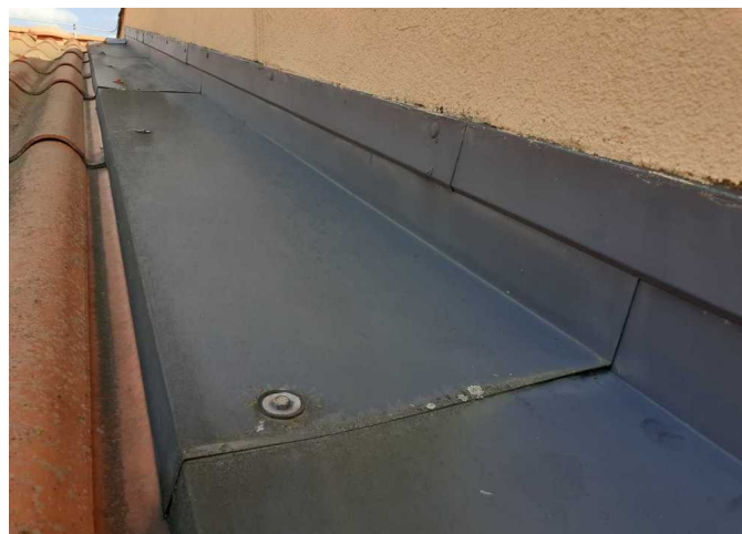
Foto /28/ Napojení střechy na zděnou nástavbu nad schodištěm
