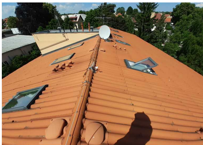
Foto /2/ Pohled na předmětnou střechu
