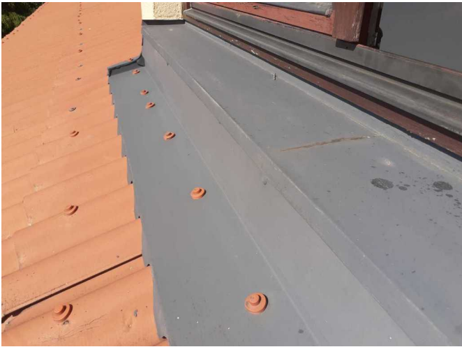
Foto /29/ Napojení střechy na zděnou nástavbu nad schodištěm v oblasti okna
