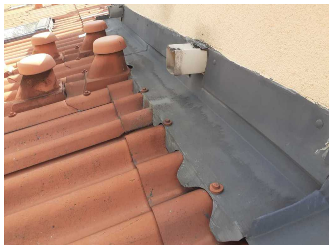
Foto /24/ Napojení střechy na zděnou nástavbu nad schodištěm
