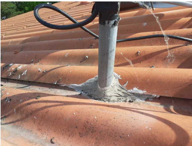
Foto /31/ Anténní stožár u hřebene střechy
