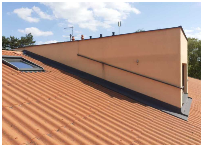
Foto /27/ Pohled na zděnou nástavbu nad schodištěm
