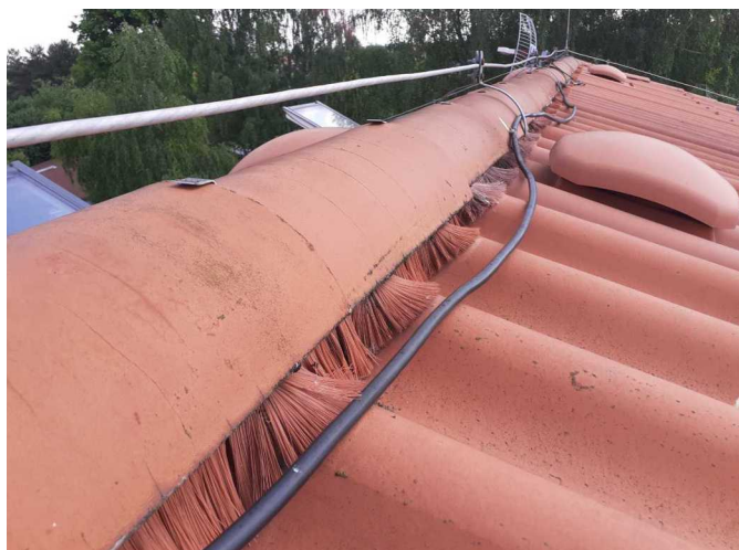
Foto /18/ Střešní hřeben
