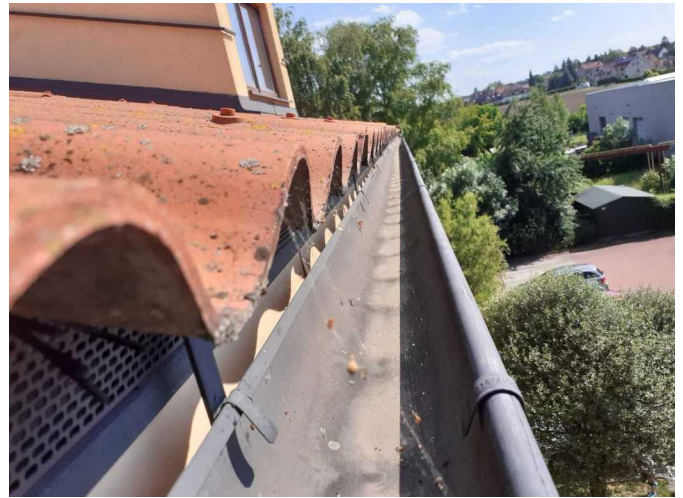
Foto /30/ Pohled na větrací pás nad podokapním žlabem
