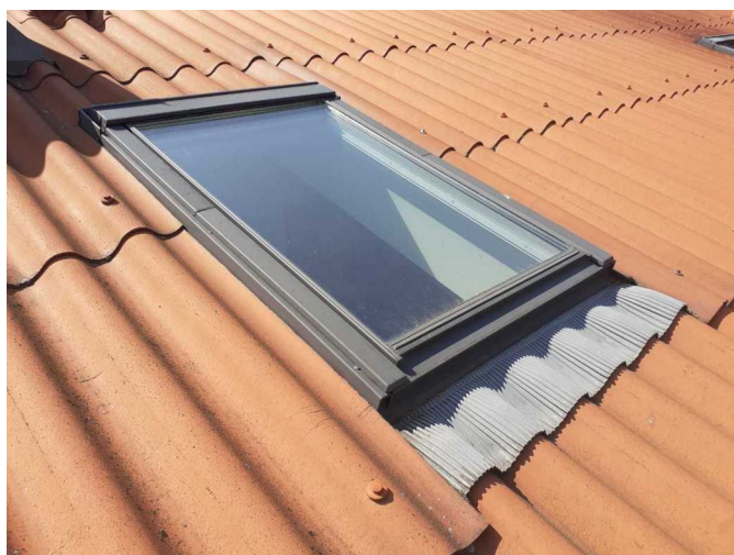
Foto /22/ Střešní kyvné okno
