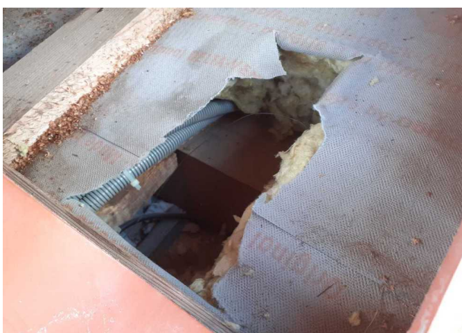
Foto 9/ Pohled na provedenou sondu
