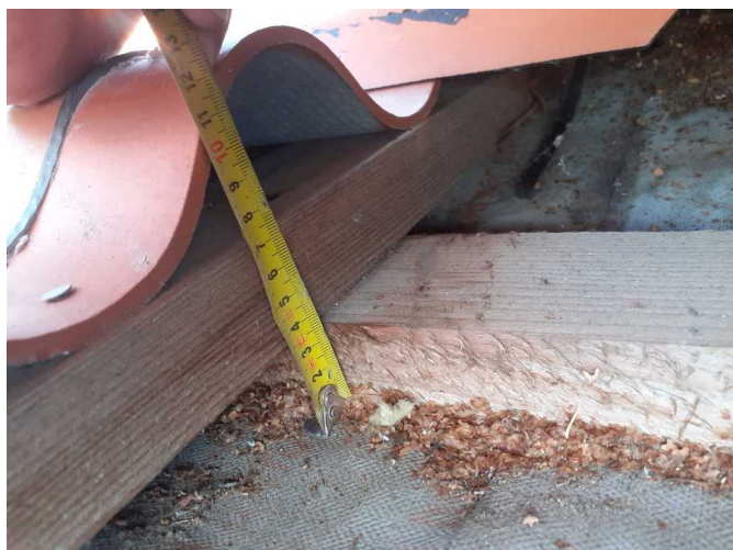
Foto 8/ Mocnost vzduchové mezery s laťováním
