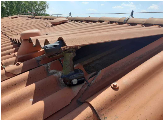
Foto 5/ Pohled na oblast provedené sondy
