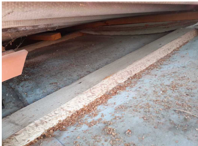
Foto 6/ Vzduchová mezera s laťováním
