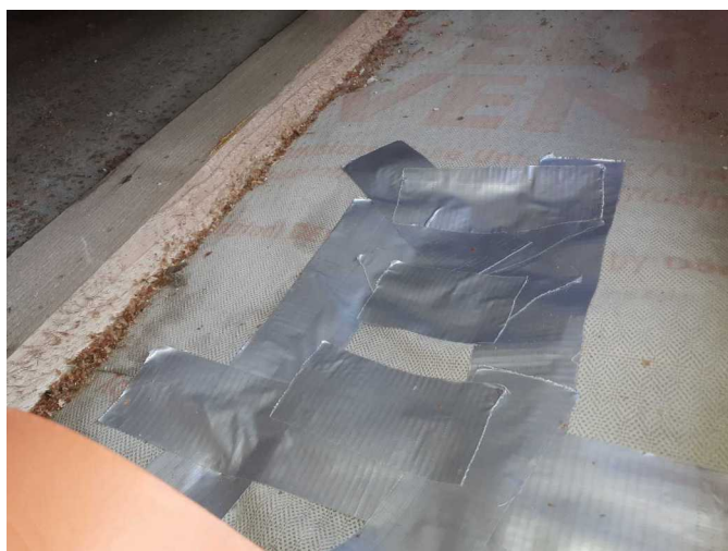
Foto /13/ Zalepení pojistné hydroizolace po provedení sondy
