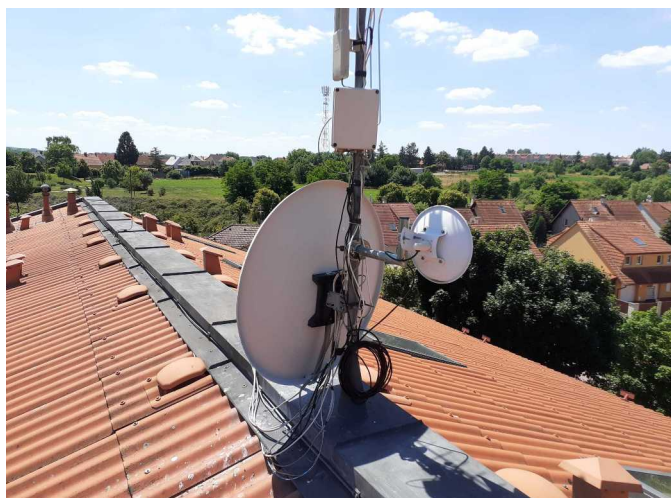
Foto /11/ Anténní stožár v hřebenové atice střechy
