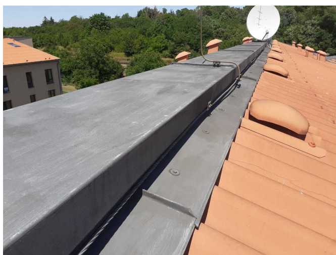
Foto /16/ Oplechování hřebenové atiky střechy
