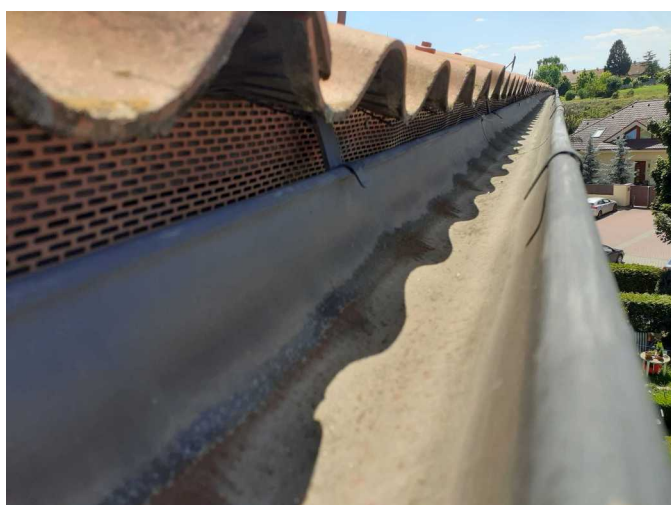
Foto /15/ Pohled na větrací pás nad podokapním žlabem
