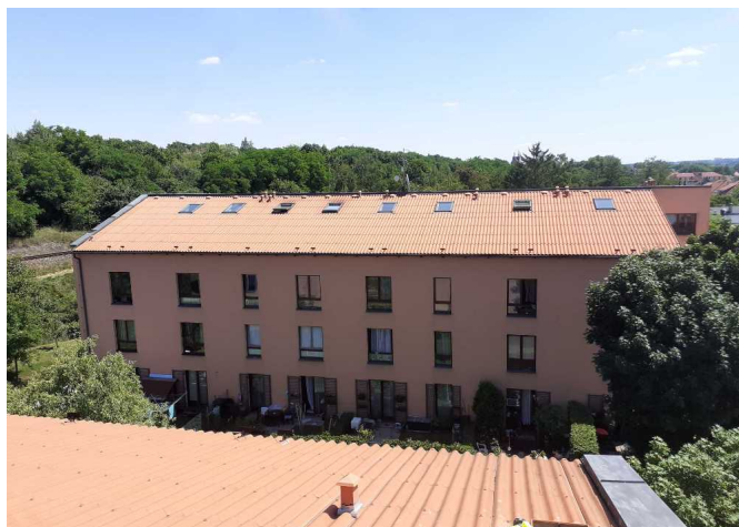
Foto /2/ Pohled na západní polovinu předmětného objektu
