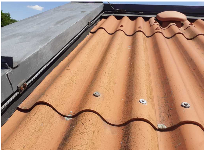
Foto /5/ Pohled na oblast provedené sondy
