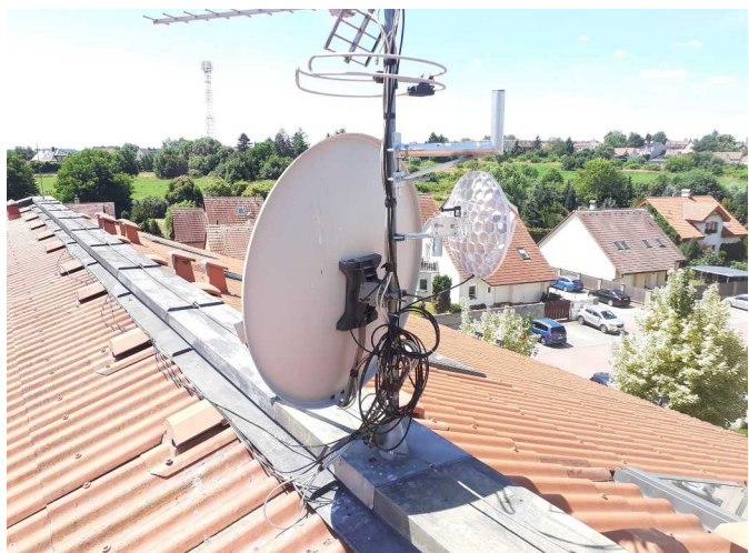
Foto /23/ Anténní stožár v hřebenové atice střechy Foto /24/ Oplechování hřebenové atiky střechy
