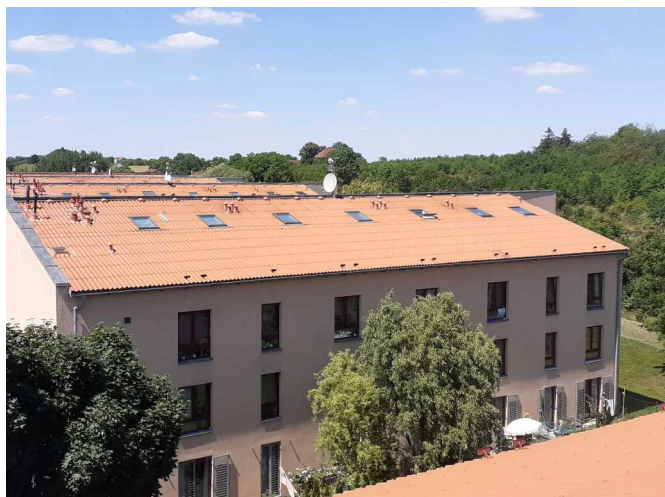
Foto /2/ Pohled na východní polovinu předmětného objektu
