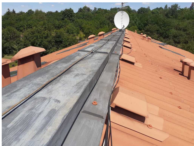
Foto /23/ Anténní stožár v hřebenové atice střechy Foto /24/ Oplechování hřebenové atiky střechy
