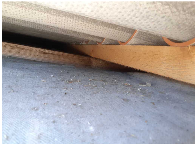
Foto /6/ Vzduchová mezera s laťováním
