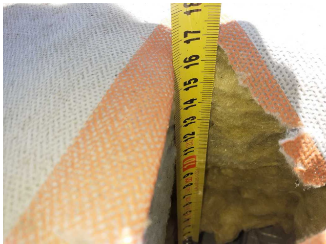
Foto /8/ Pohled do sondy na tepelnou izolaci z minerální vlny
