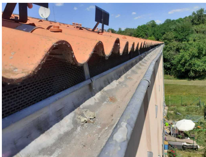
Foto /20/ Pohled na větrací pás nad podokapním žlabem
