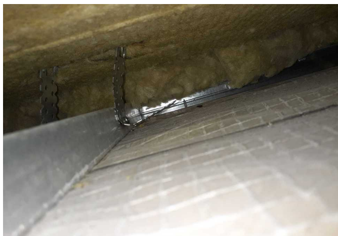
Foto /10/ Vzduchová mezera nad SDK podhledem s parotěsnící PE fólií
