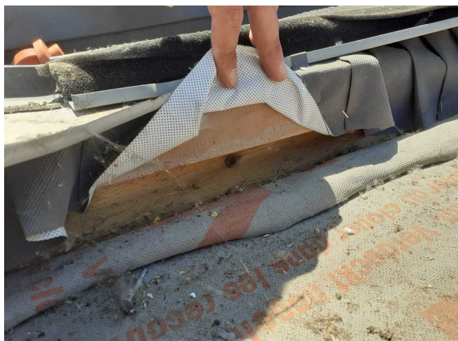
Foto /18/ Napojení pojistné hydroizolace na konstrukci střešního okna
