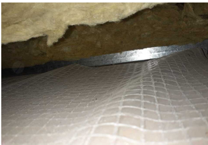
Foto /9/ Vzduchová mezera nad SDK podhledem s parotěsnící PE fólií
