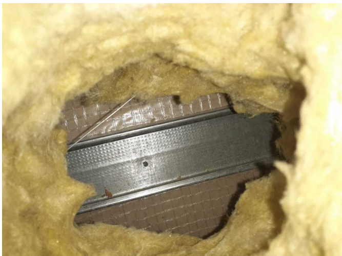
Foto /7/ Pohled do sondy na tepelnou izolaci z minerální vlny a parotěsnící fólii
