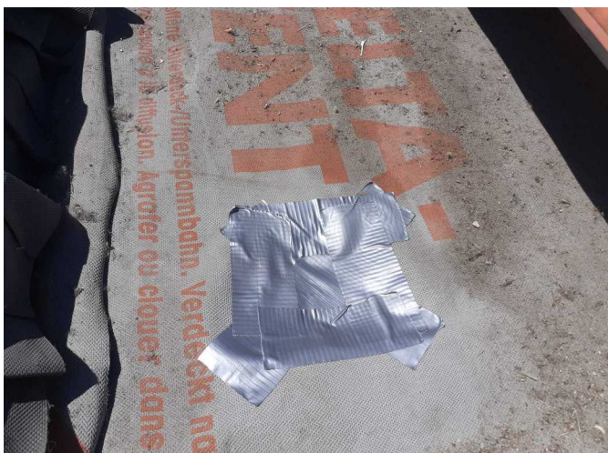
Foto /11/ Zalepení pojistné hydroizolace po provedení sondy
