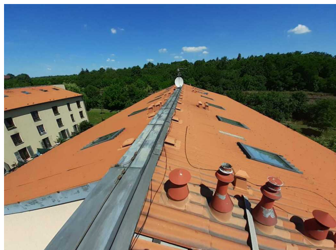
Foto /12/ Pohled na předmětnou šikmou střechu
