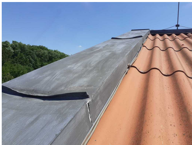
Foto /22/ Vnitřní okraj střechy v oblasti štítu
