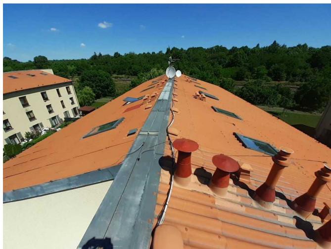
Foto /13/ Pohled na předmětnou šikmou střechu
