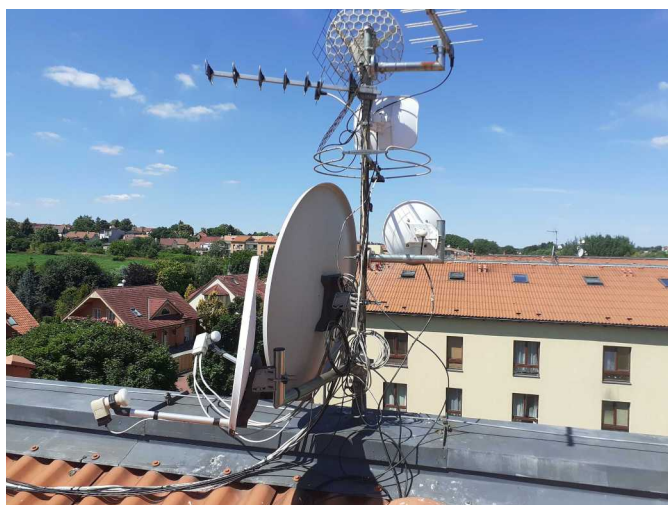
Foto /28/ Anténní stožár v hřebenové atice střechy
