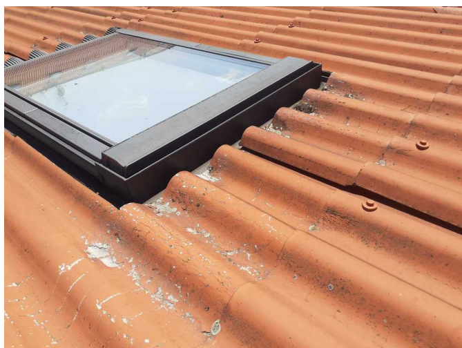
Foto /19/ Pohled na vrchní část střešního okna
