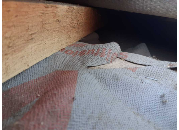
Foto /6/ Vzduchová mezera s laťováním
