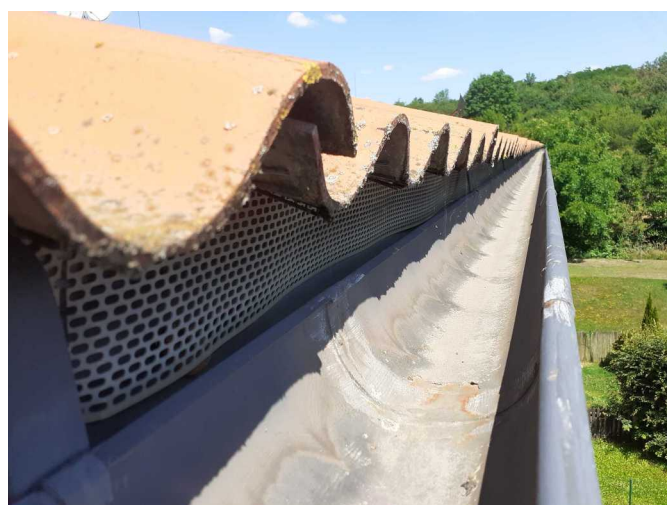
Foto /22/ Pohled na větrací pás nad podokapním žlabem
