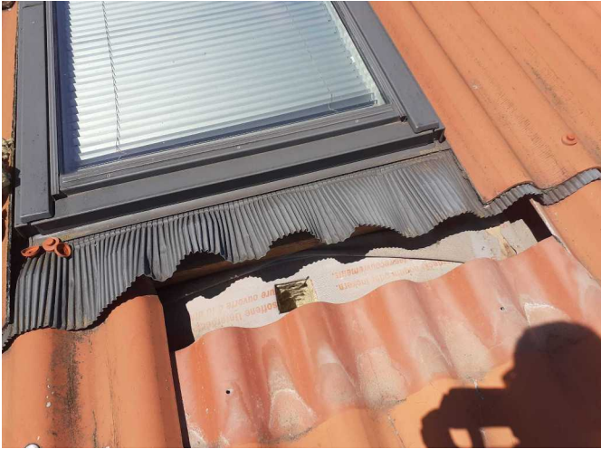
Foto /5/ Pohled na oblast provedené sondy
