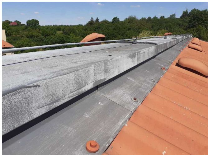
Foto /24/ Oplechování hřebenové atiky střechy
