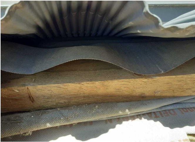
Foto /7/ Vzduchová mezera s laťováním
