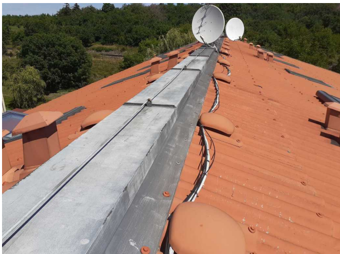
Foto /23/ Oplechování hřebenové atiky střechy
