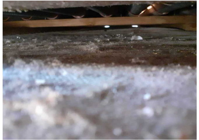
Foto /8/ Vzduchová mezera s laťováním
