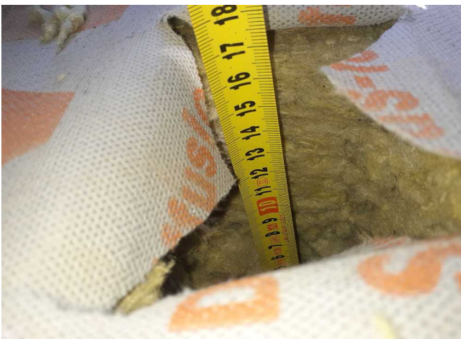
Foto /9/ Pohled do sondy na tepelnou izolaci z minerální vlny
