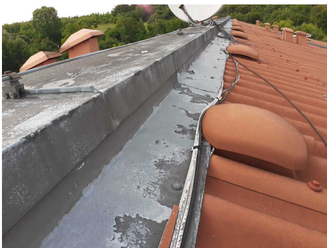
Foto /25/ Oplechování hřebenové atiky střechy
