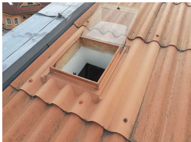
Foto /24/ Střešní výlez
