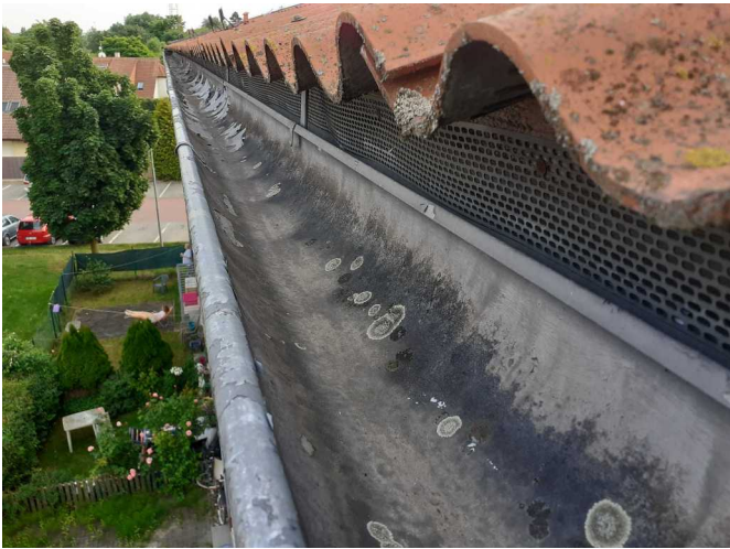
Foto /29/ Pohled na větrací pás nad podokapním žlabem
