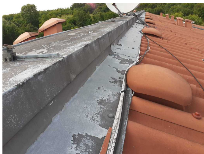
Foto /26/ Oplechování hřebenové atiky střechy
