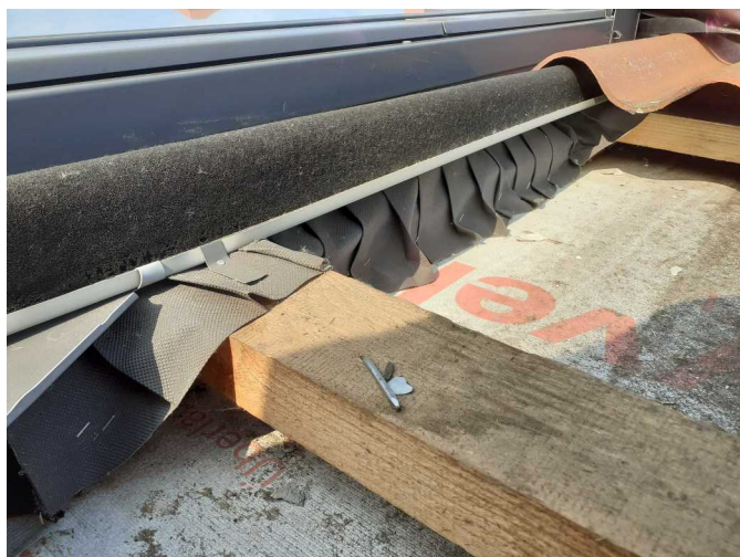
Foto /21/ Pohled na spodní část lemování střešního okna
