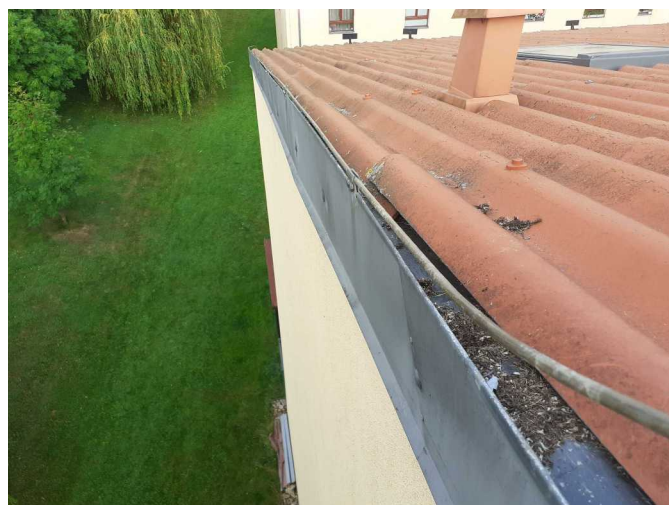
Foto /28/ Vnější okraj střechy v oblasti štítu
