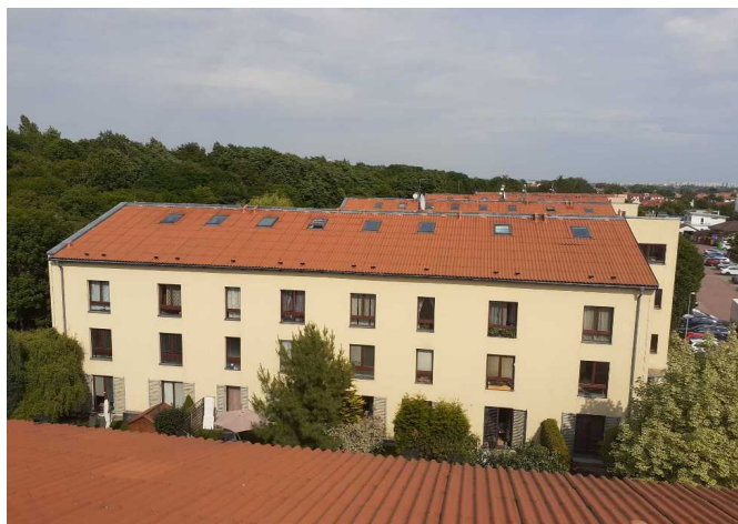
Foto /2/ Pohled na západní polovinu předmětného objektu
