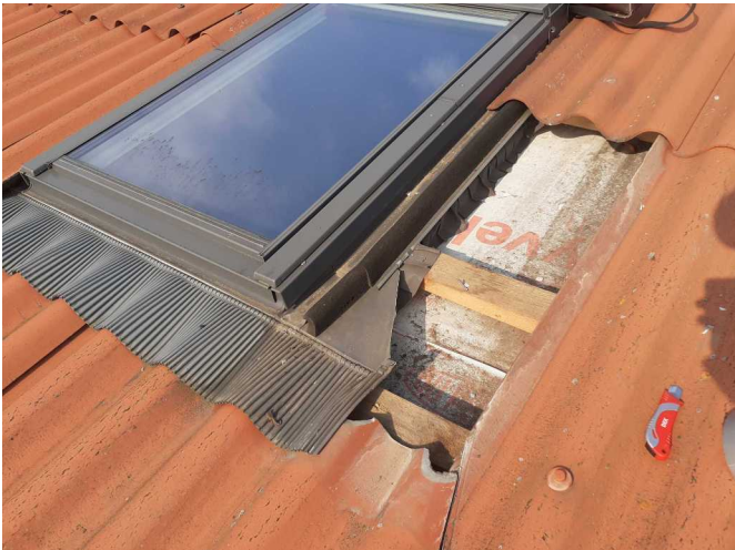
Foto /5/ Pohled na oblast provedené sondy
