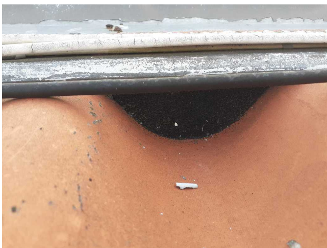
Foto /27/ Pohled pod oplechování hřebenové atiky střechy
