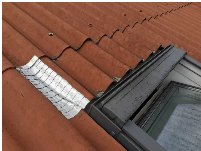
Foto /20/ Pohled na vrchní část střešního okna
