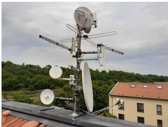
Foto /26/ Anténní stožár v hřebenové atice střechy
