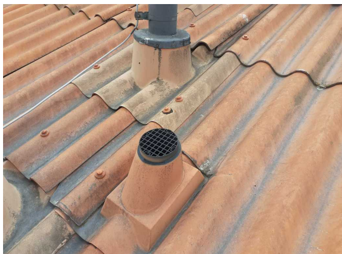
Foto /17/ Komínky vytápění a odvětrání
