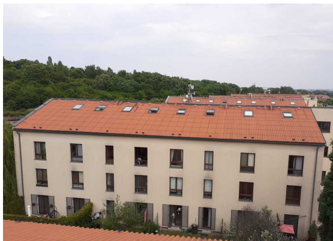
Foto /2/ Pohled na západní polovinu předmětného objektu
