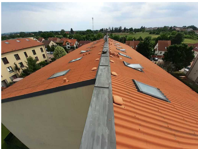
Foto /13/ Pohled na předmětnou šikmou střechu
