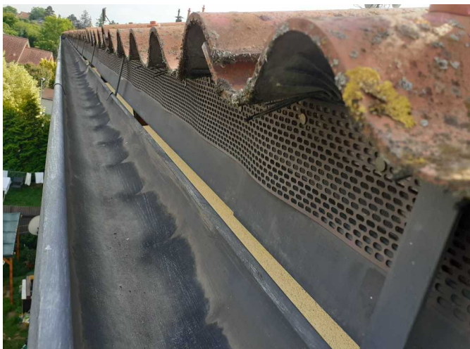
Foto /23/ Pohled na větrací pás nad podokapním žlabem
