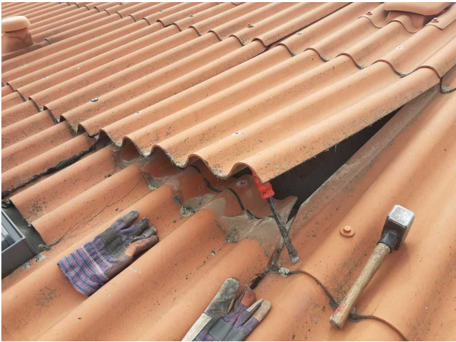
Foto /5/ Pohled na oblast provedené sondy
