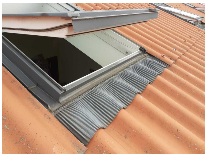
Foto /21/ Pohled na spodní část střešního okna
