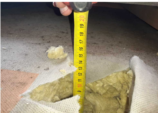
Foto /9/ Pohled do sondy na tepelnou izolaci z minerální vlny
