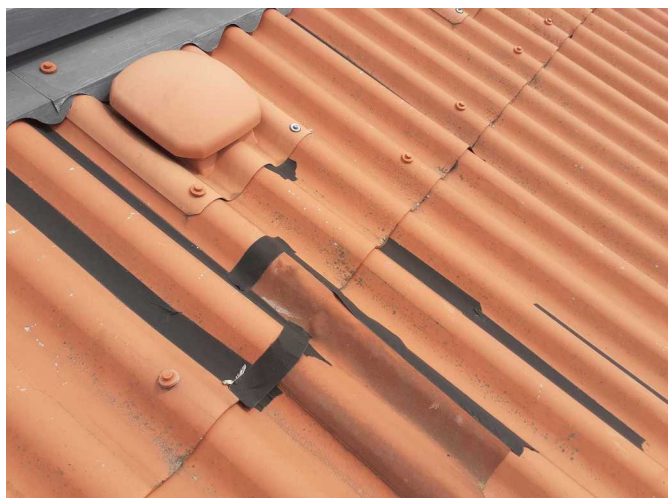
Foto /18/ Jeden z větracích komínků provětrávané vzduchové mezery a opravy střešní krytiny páskou
