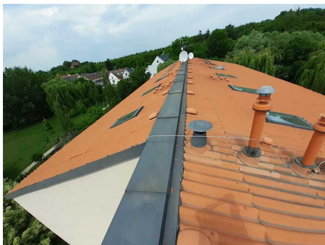
Foto /15/ Pohled na předmětnou šikmou střechu
