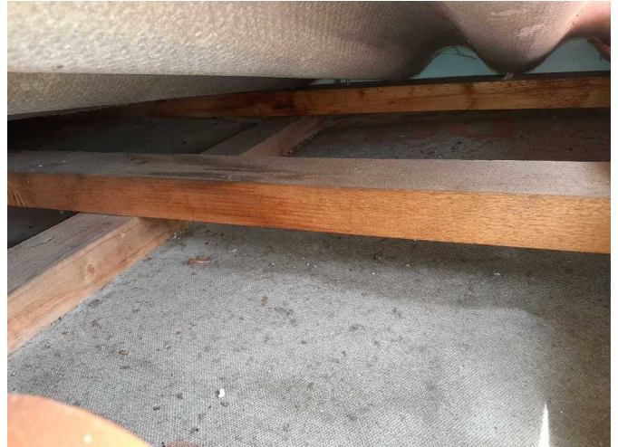
Foto /6/ Vzduchová mezera s laťováním
