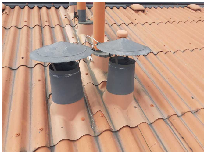
Foto /18/ Komínky vytápění a odvětrání
