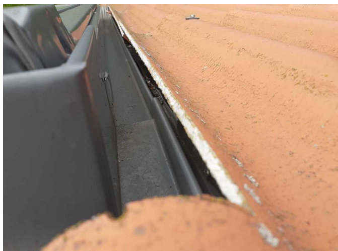
Foto /23/ Pohled na boční část střešního okna
