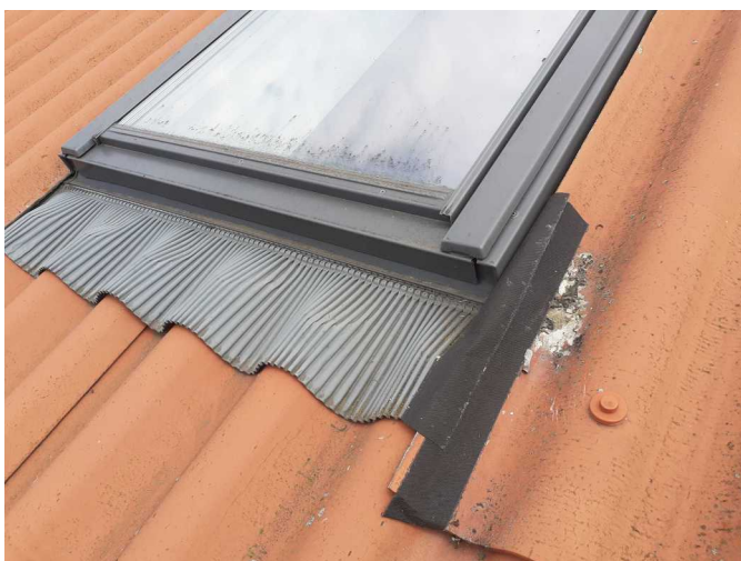
Foto /21/ Pohled na spodní část střešního okna
