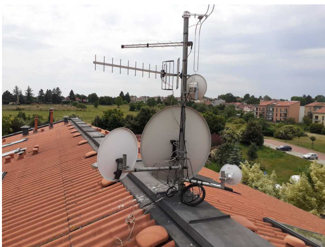
Foto /31/ Anténní stožár v hřebenové atice střechy
