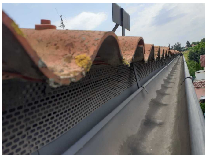
Foto /27/ Pohled na větrací pás nad podokapním žlabem
