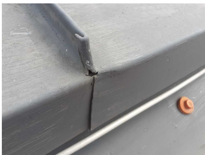
Foto /34/ Proděravění oplechování atiky ve spoji
