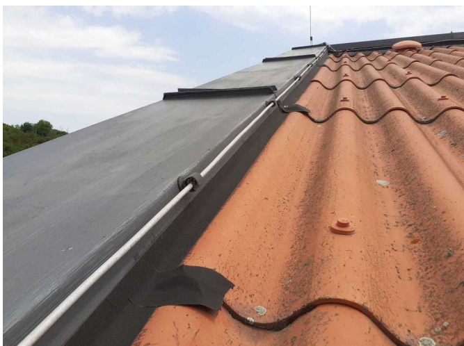
Foto /29/ Vnitřní okraj střechy v oblasti štítu
