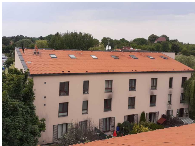
Foto /2/ Pohled na východní polovinu předmětného objektu
