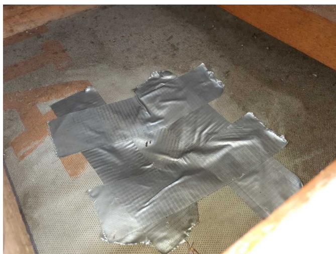
Foto /13/ Zalepení pojistné hydroizolace po provedení sondy
