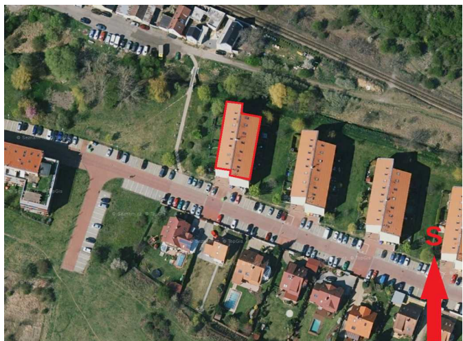
Foto /1/ Situace s vyznačením předmětné šikmé střechy objektu (mapy.cz)
