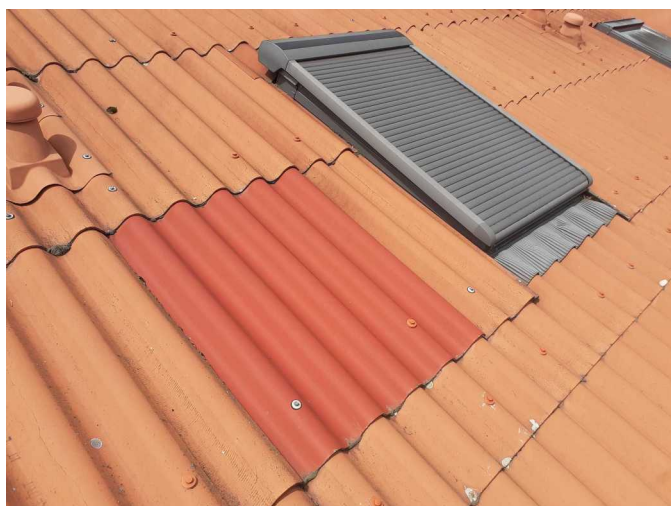
Foto /25/ Oprava střešní krytiny a okno s předsazenými roletami
