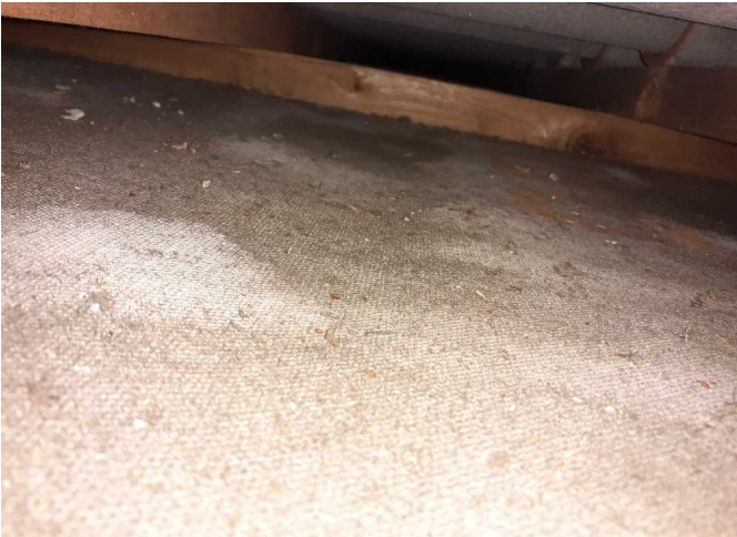
Foto /7/ Povrch pojistné hydroizolace v místě sondy
