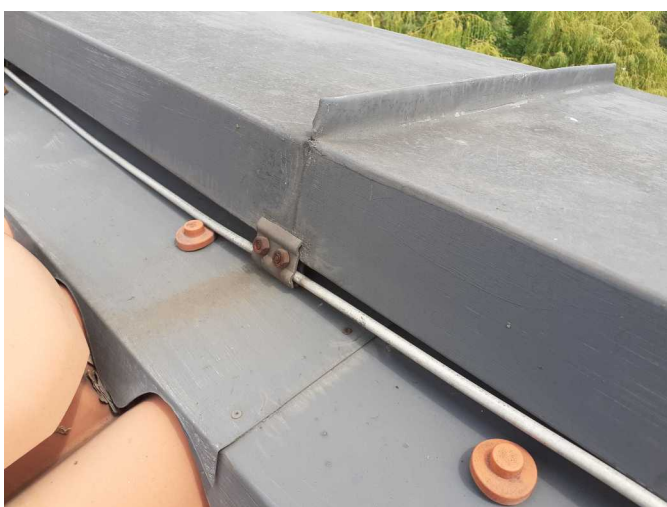
Foto /33/ Oplechování hřebenové atiky střechy
