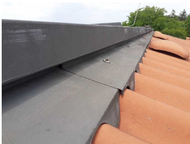
Foto /32/ Oplechování hřebenové atiky střechy
