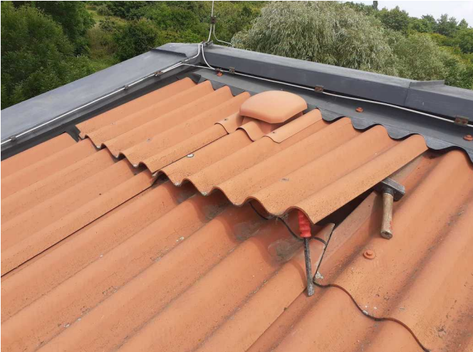
Foto /5/ Pohled na oblast provedené sondy
