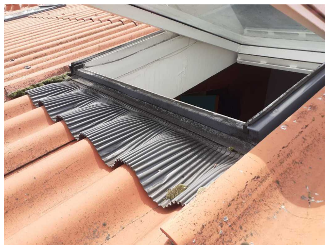
Foto /22/ Pohled na spodní část střešního okna
