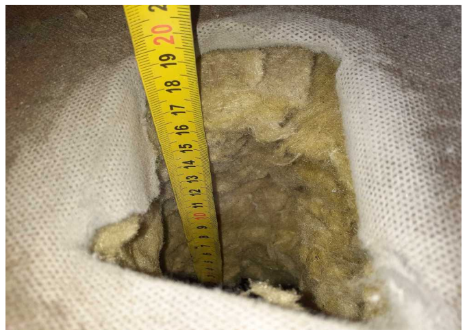
Foto /10/ Pohled do sondy na tepelnou izolaci z minerální vlny
